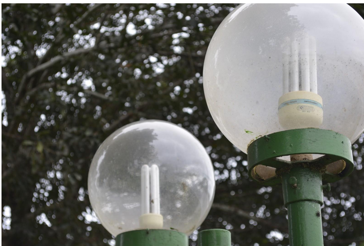
Figura 4 – Luminária em más condições de conservação
