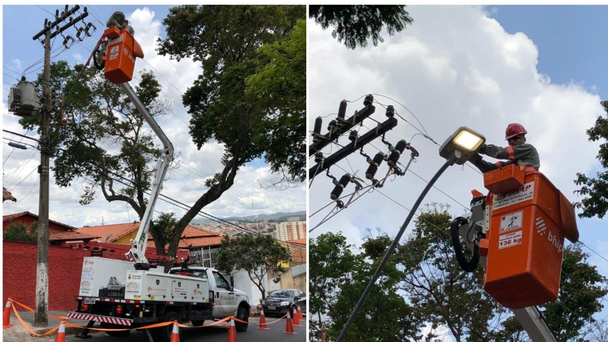
Figura 3 – Instalação de Luminária LED em Via Pública
