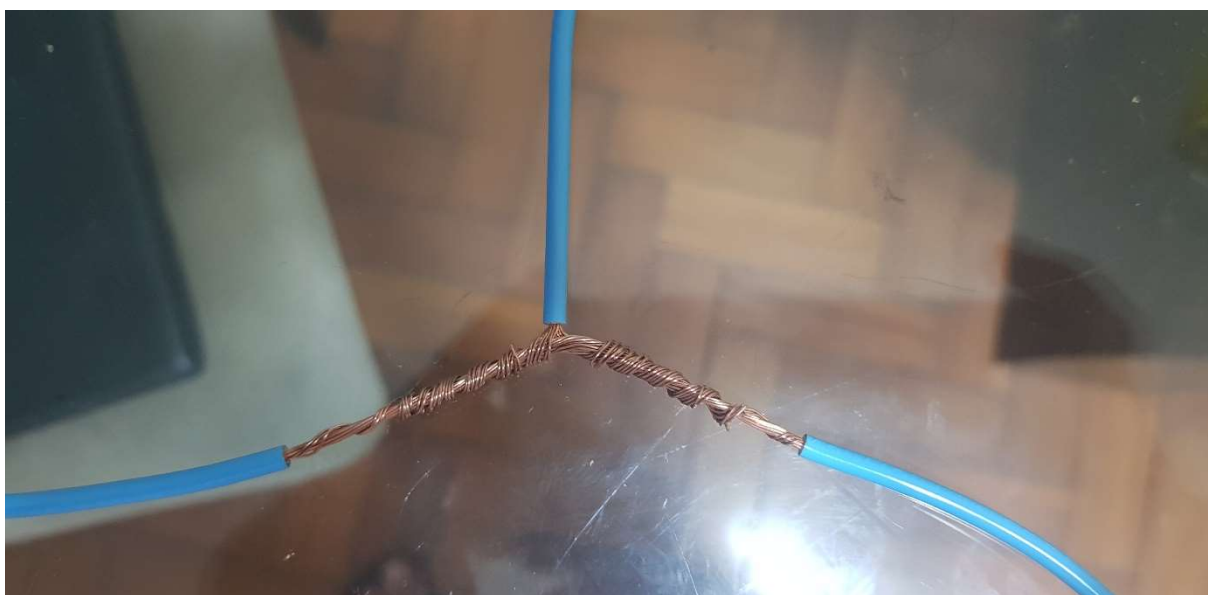
Figura 16 – Emenda de derivação
