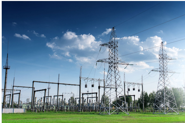
Figura 1 – Entrada de linha em uma subestação de energia.
