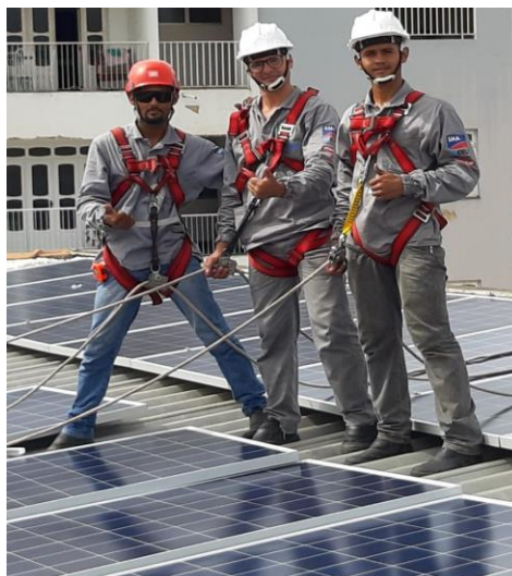
Figura 23 – Acompanhamento da instalação
