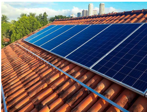
Figura 1 – Sistema fotovoltaico com painéis solares
