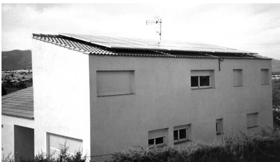
Figura 4 – Sistema fotovoltaico integrado a uma edificação residencial (SOLO del Real, Madri, Espanha)
