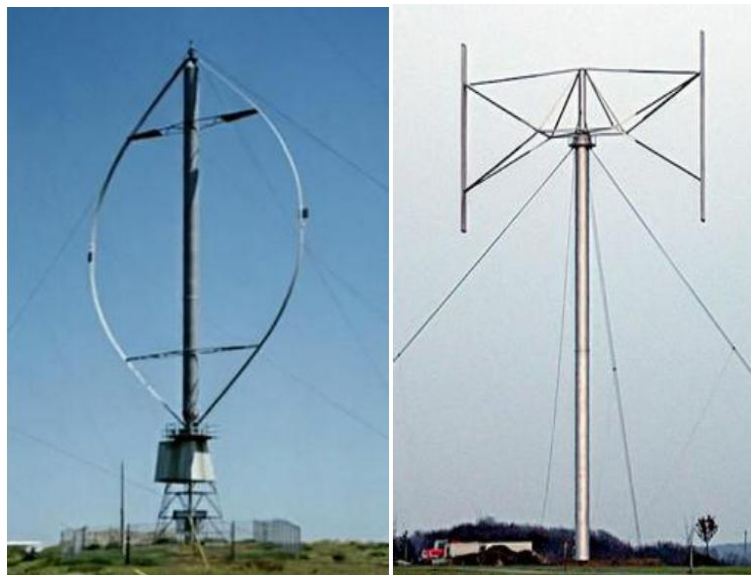
Figura 8 – Turbinas Darrieus: (a) de pás curvas; (b) de pás retas
