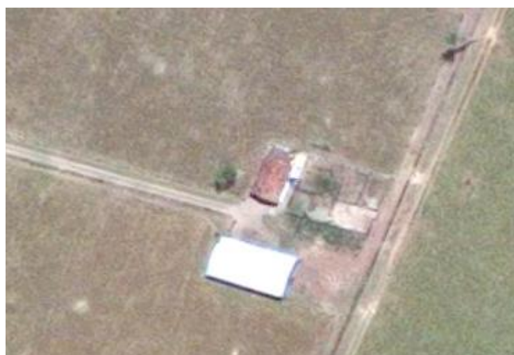
Figura 2 - Vista superior do local exato do novo ponto de entrega de energia elétrica. Fonte: Google Maps.
